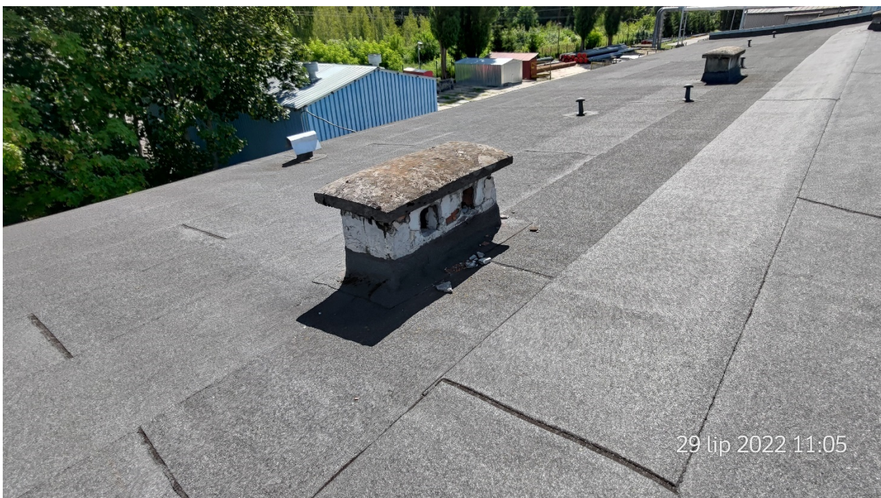
Fot. 2. Uszkodzenia kominów
